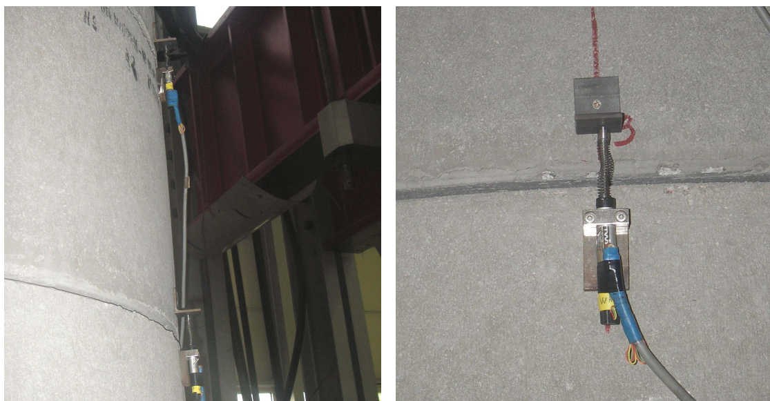
Bild 3 Wegaufnehmer zur Messung der Verformung in den Schachtverbindungen
